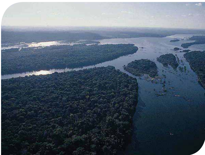
Um dos desafios da Eletronorte: o Rio Tocantins, onde foi construída a usina de Tucuruí (PA)
