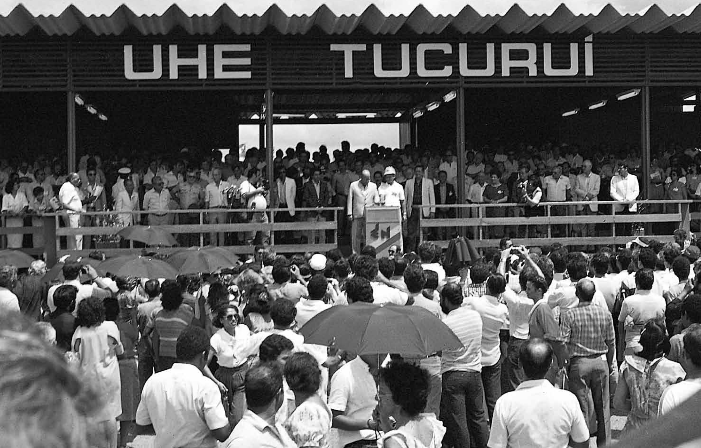
O presidente da República João Baptista Figueiredo aciona a primeira máquina da Usina Hidrelétrica Tucuruí, no Rio Tocantins, município de Tucuruí (PA), novembro de 1984
