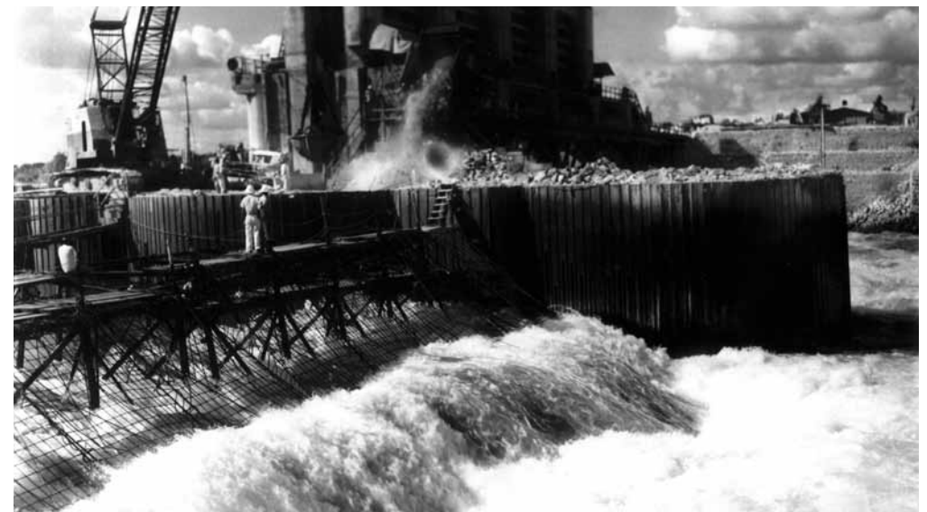
Obras da Usina Hidrelétrica Paulo Afonso I: fechamento do Rio São Francisco, 1953
